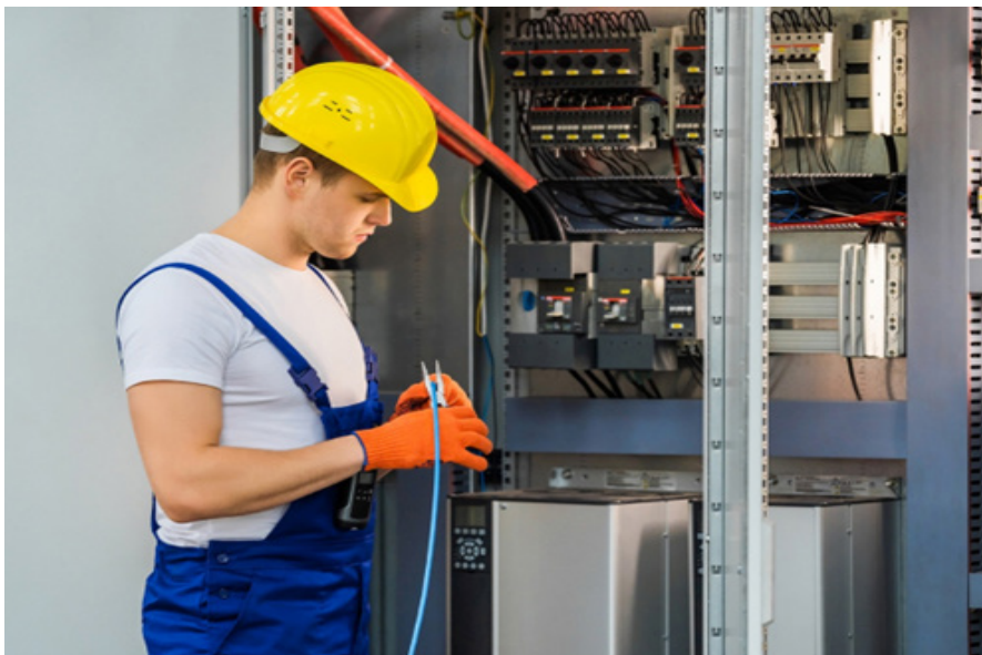
Service og utbedring i frakoblet hovedtavle
