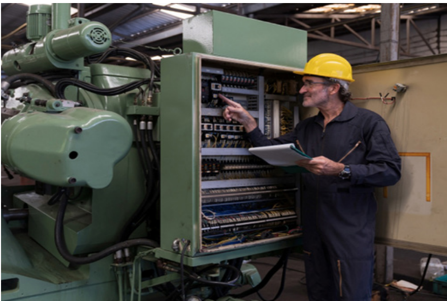
Ettersyn og vedlikeholdssjekk i frakoblet maskintavler
